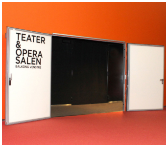
Geluidsisolerende deur theater in Noorwegen
