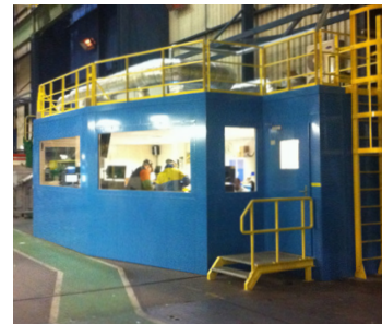
Geluidwerende cabine in productieruimte
